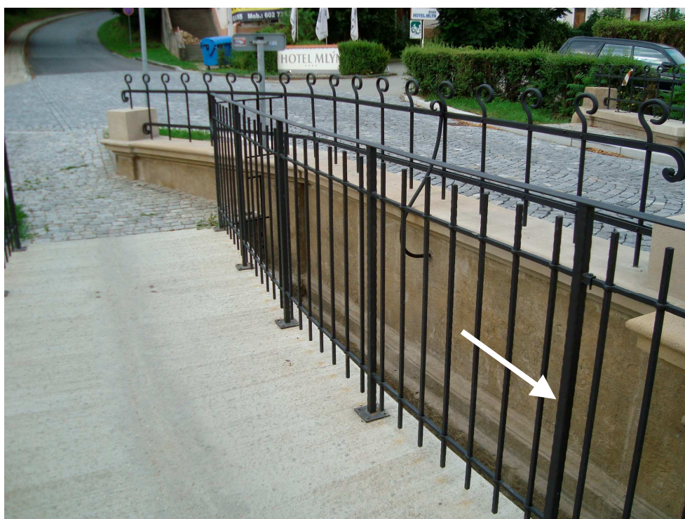
Foto č.2 – Vzor kovaného zábradlí na bet. lávce cca 300m proti směru toku od projektovaného mostu
