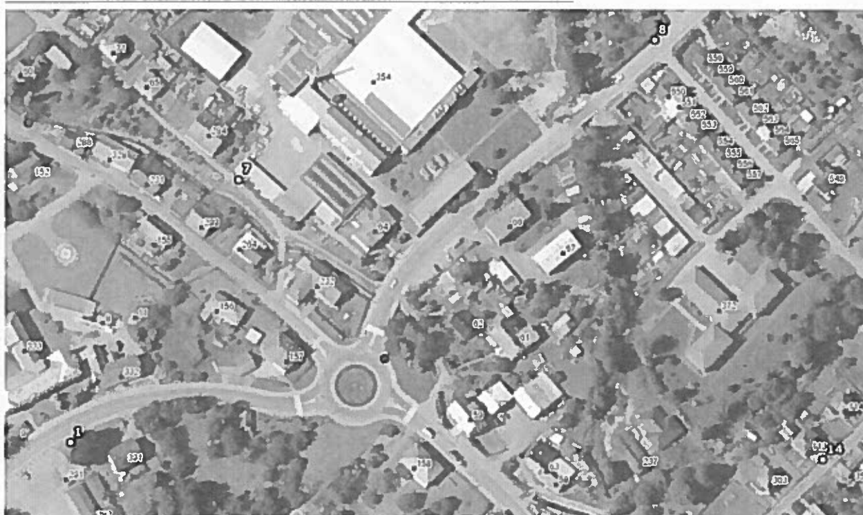
Umístění hlásičů v obci Červená Voda – detail 4
