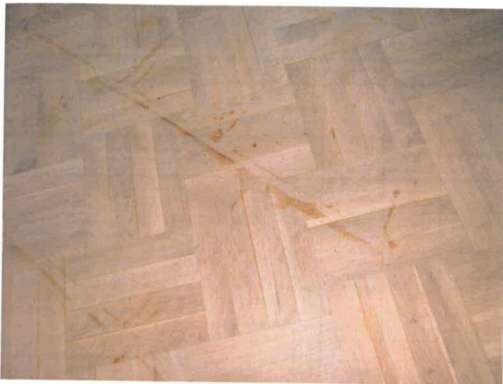
Obr. 1 - Znečištěné parketové podlahy po 1 suchém broušení
