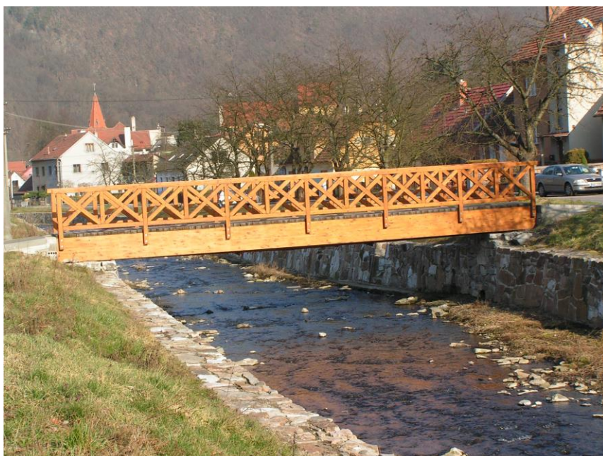
Umístění vodočetné latě u dřevěné lávky přes Nedvědičku
