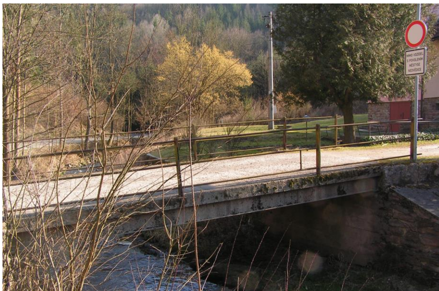
Umístění hladinoměru přes Nedvědičku v místní části Pernštejn
