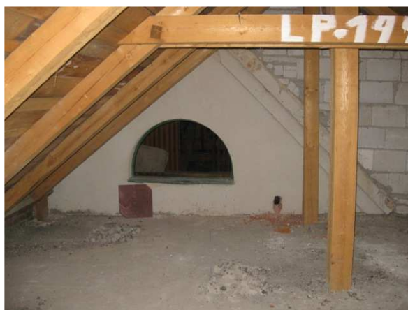
Obr.22: Okno mezi starou budovou SO01 a přístavbou SO02
