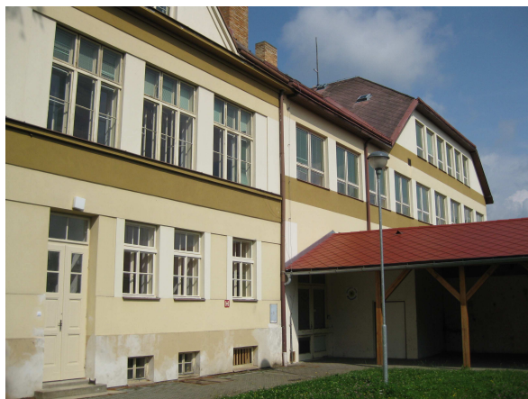
Obr.2: Východní průčelí staré budovy SO01 s návazností na přístavbu SO02
