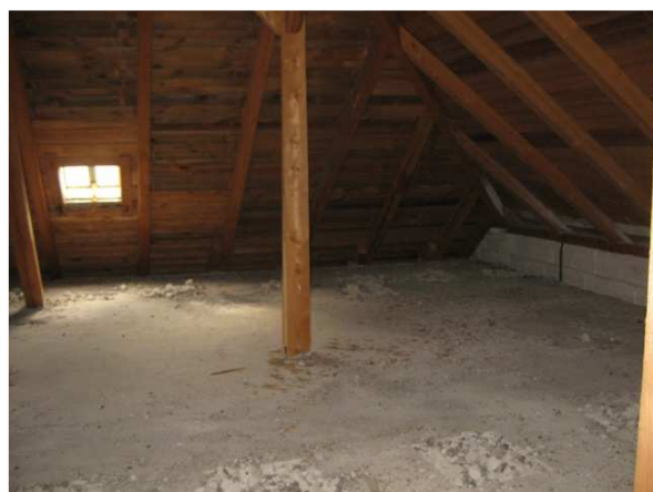
Obr.21: Krov v přístavbě SO02
