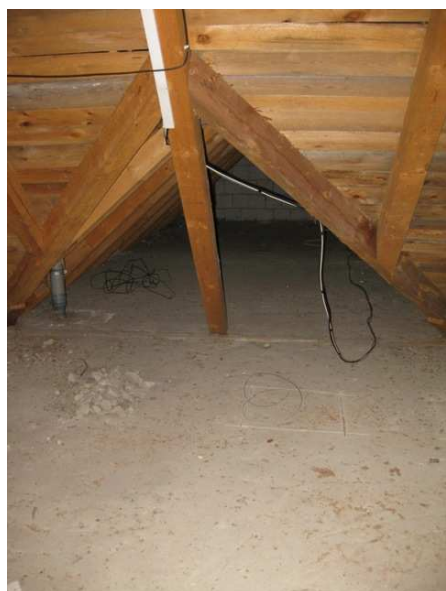
Obr.19: Krov v přístavbě SO02
