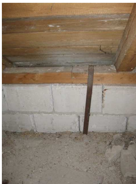
Obr.20: Krov v přístavbě SO02 – nadezdívka
