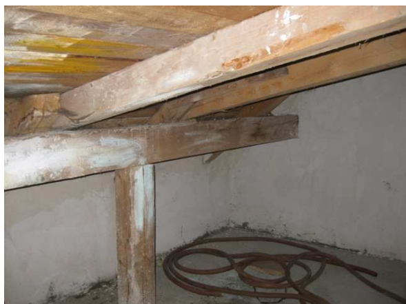
Obr.26: Krov nad 2.NP přístavba SO02
