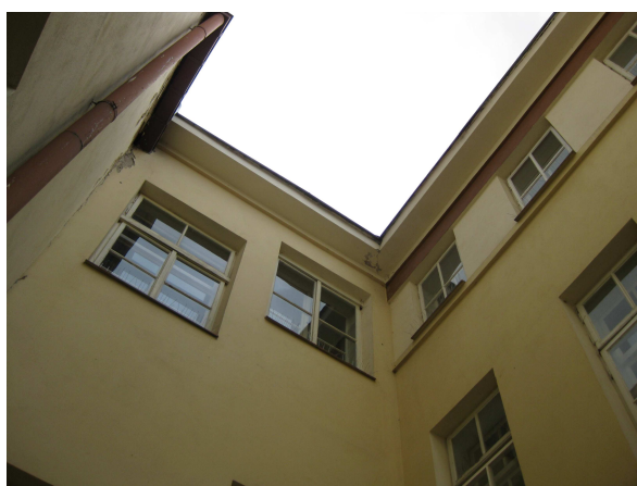
Obr.4: Pohled do dvora staré budovy SO01 s návazností na přístavbu SO02
