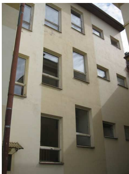
Obr.10: Pohled do dvora přístavby SO02 schodiště – západní fasáda
