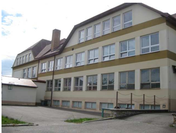
Obr.5: Východní průčelí přístavby SO02 s návazností na starou budovu SO01
