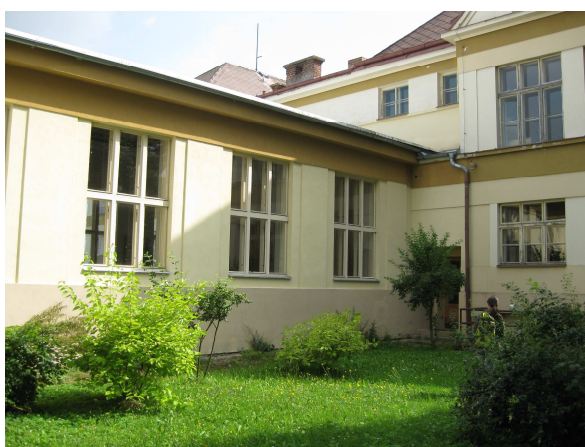
Obr.3: Tělocvična SO03 s návazností na starou budovu SO01 – jižní průčelí
