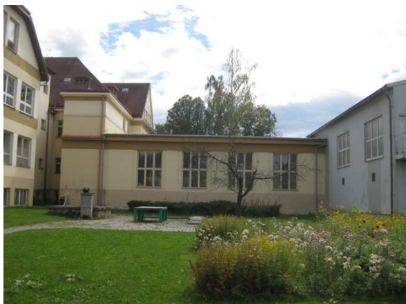
Obr.7: Tělocvična SO03 – severní průčelí
