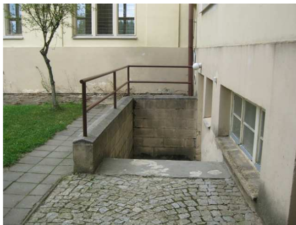
Obr.16: Schodiště do suterénu na západním průčelí staré budovy SO01
