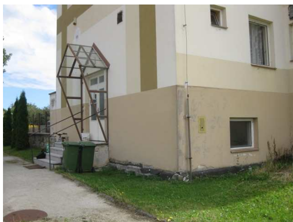
Obr.6: Severní průčelí přístavby SO02 – vstup do jídelny
