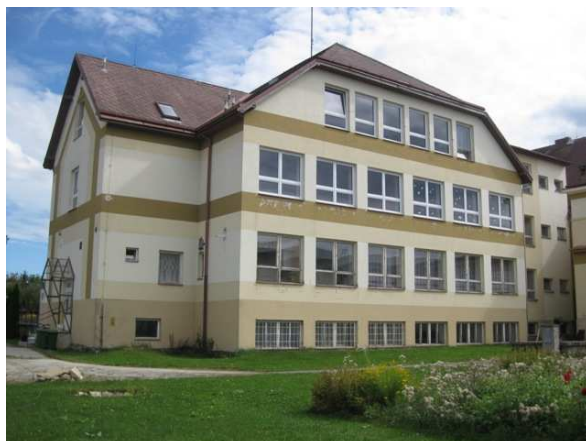
Obr.8: Západní průčelí přístavby SO02
