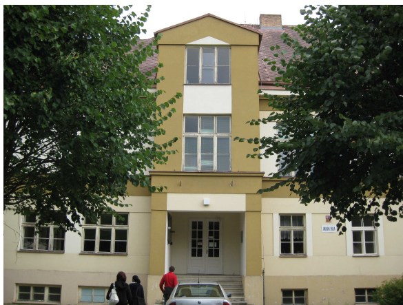
Obr.1: Hlavní vstup do ZŠ stará budova SO01
