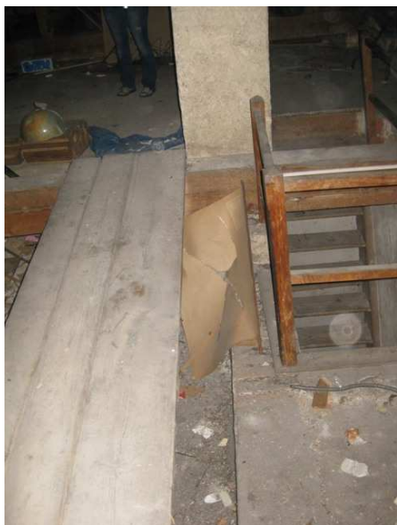
Obr.25: Schodiště na půdu staré budovy SO01
