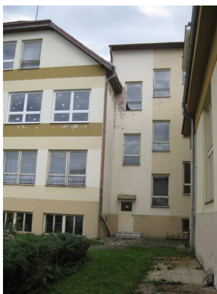
Obr.12: Západní průčelí přístavby SO02, vstup na dvorek
