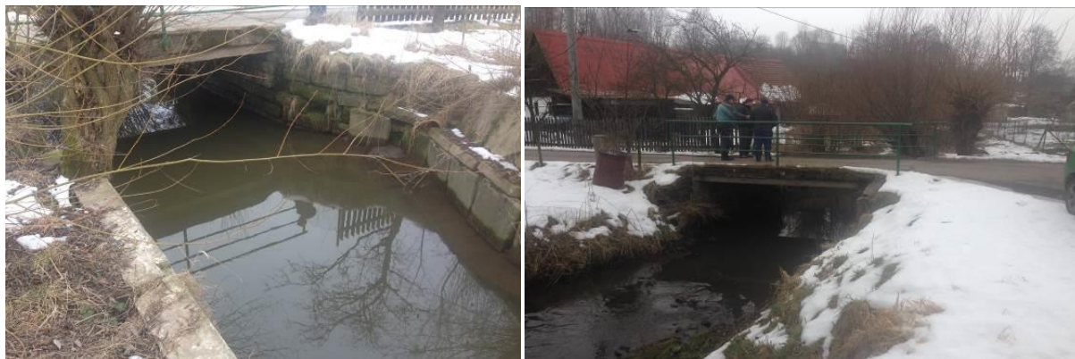
Fotodokumentace stávajícího stavu
