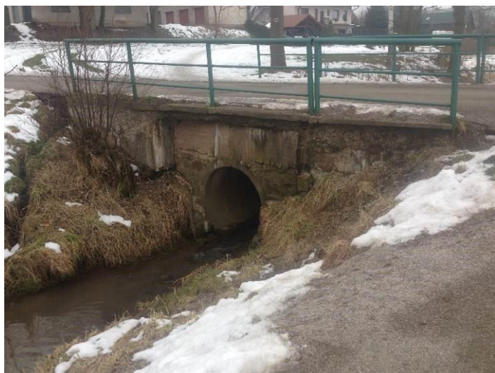
Pohled na stávající most
